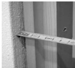
Bild 4: Distanz Blindstock Wandlaibung
