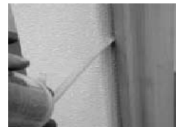
Bild 6: Zwischenraum ausschäumen
