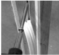
Bild 11: Kompriband (z.B. mit 300 Pascal 20 x 2,0 mm)
