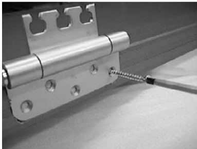
Bild 18: Band mit Türblatt verschrauben
