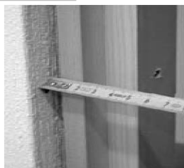
Bild 4: Abstand Blindstock Wandaubung
