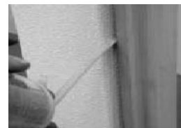
Bild 6: Zwischenraum ausschäumen
