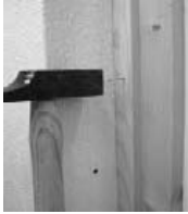
Bild 20: Montage der Wandanschlussleisten
