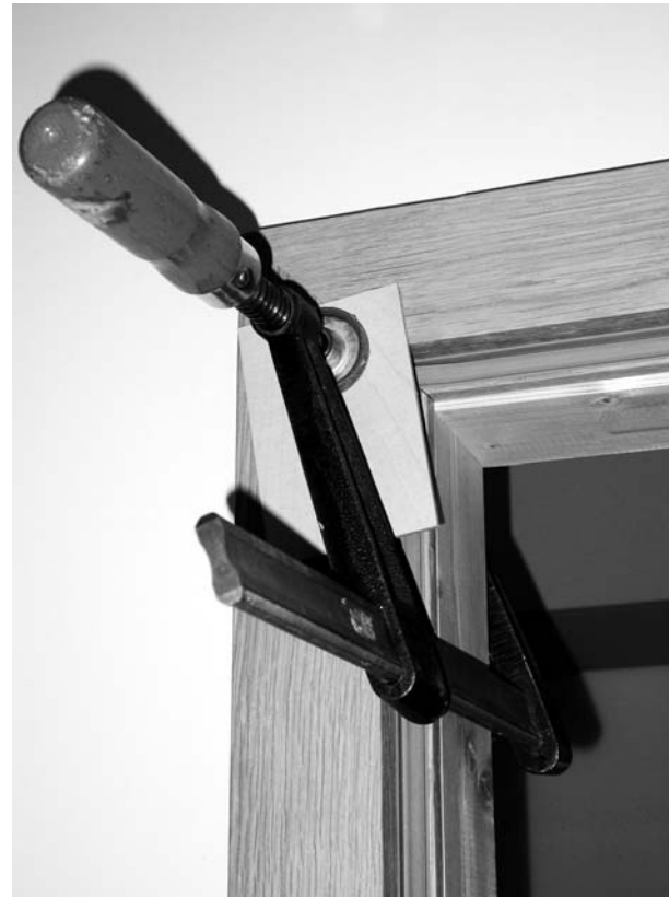
Bild 2: Nach dem Hinterfütern fixieren.
