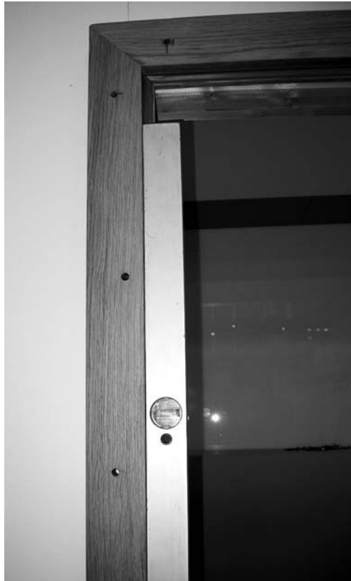
Bild 1: Blendrahmen mit der Wasserwaage einrichten.
