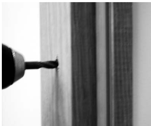
Bild 1: Vorbohren.
